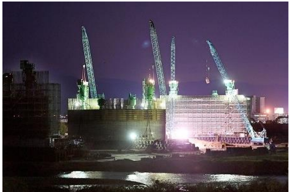
▲夜間も行われている九頭竜川橋の橋脚工事のようす
